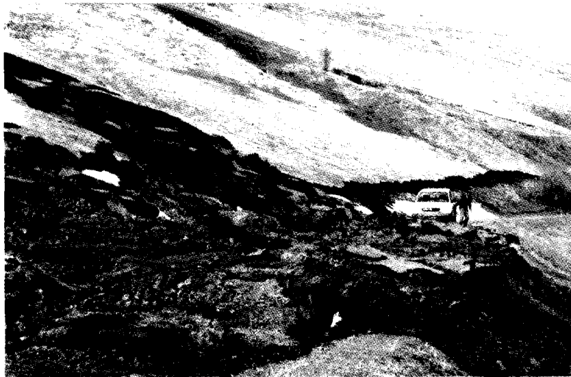
Şəkil 18. Sürüşmə nəticəsində landşaft deformasiya edilmiş, torpaq səthi dağılmışdır. Ərazi yararsız vəziyyətə düşmüşdür.
