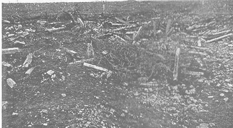
Şəkil 34. Aşağı Əbdürrəhmanlı kəndinin hərbi əməliyyatları nəticəsində xarabazara çevrilməsi. Üzümlü bağın dağıdılması
