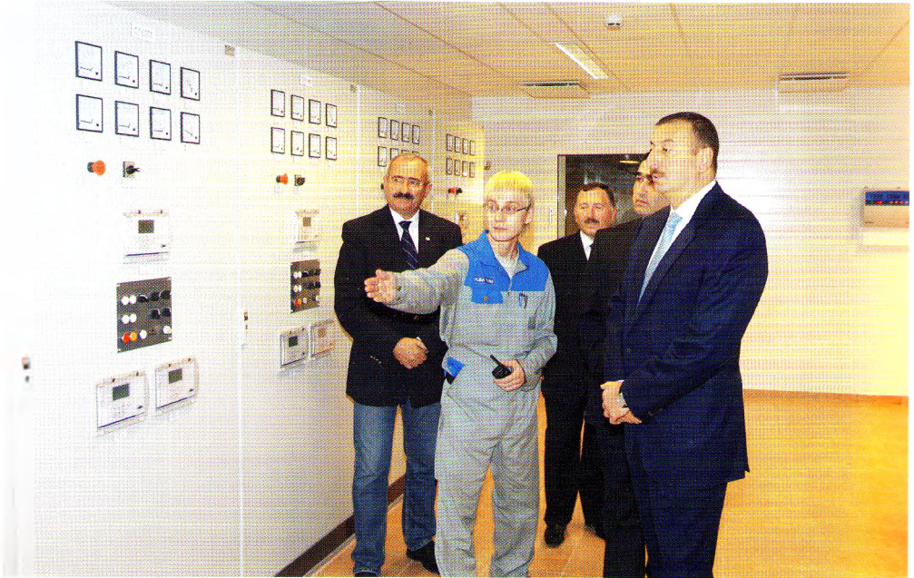
Şəki modul tipli elektrik stansiyası ilə tanışlıq. 14.10.2006.
