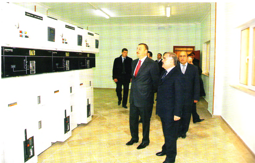
Naxçıvan modul tipli elektrik stansiyasının açılış mərasimi. 20.12.2009
